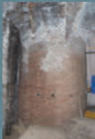
Le pilier central du soubassement
